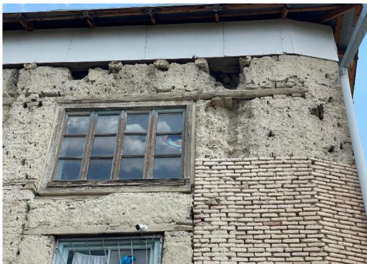
Şəkil 5. Üçtürləngə məscidində istifadə olunmuş ağac konstruksiya (Məhəmməd Bayramov).
